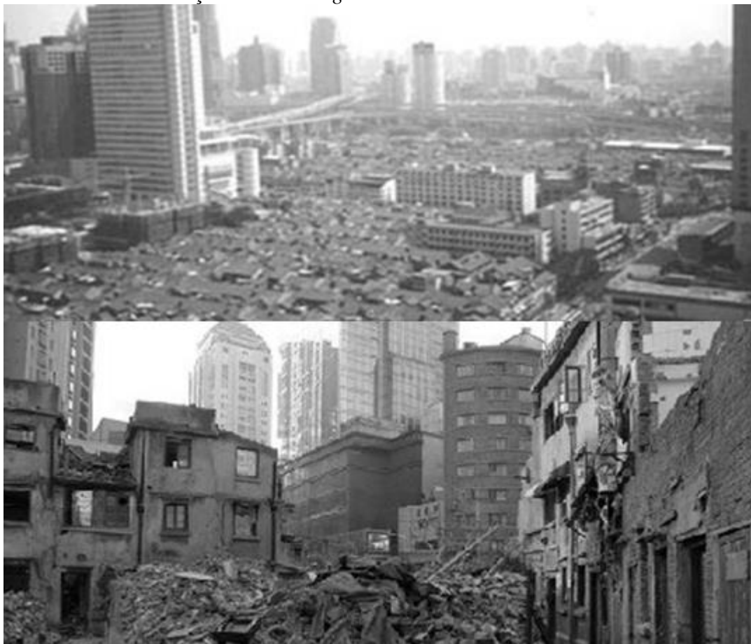
FIGURA 5 - Destruição de um lilong
