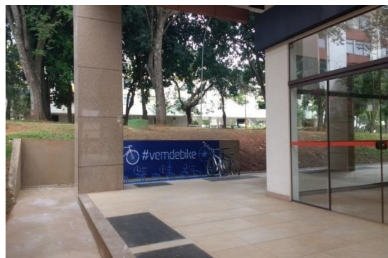
Foto 08: Detalhe de novo bloco de construção mais recente nas 413. Fonte: autores.
